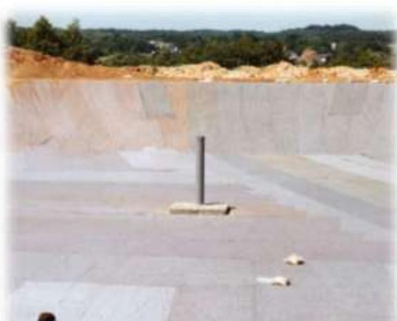
Photo mise en place de la géo membrane soudure par joints.
